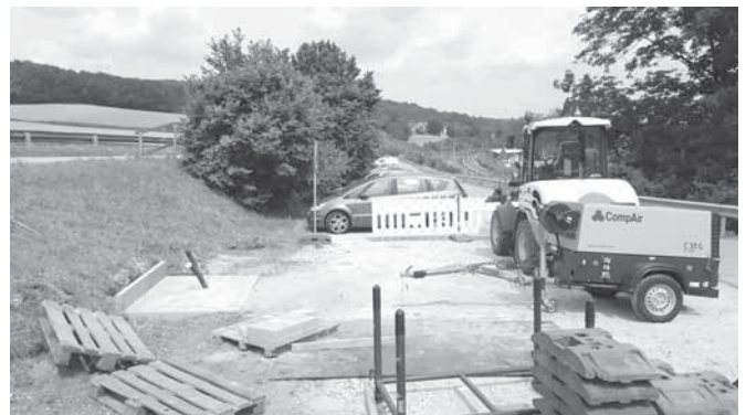
Arbeiten für Ladesäule (Foto: Nutz)
