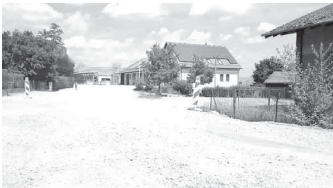
Bahnhofstraße - Ausbaurbeiten gehen voran (Foto: Nutz)
