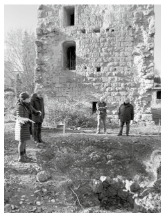
Bergfried in Viehhausen Zisterne Bild: Gemeinde Sinzing
