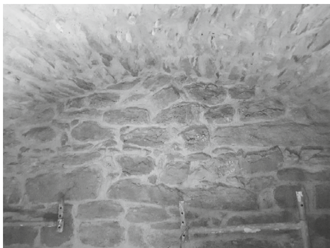
Turmgewölbe nach der Sanierung Bild: Alois Renner
