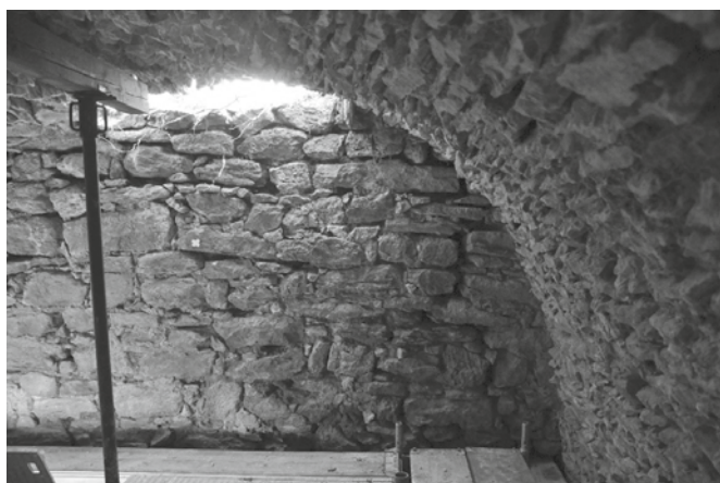
Turmgewölbe vor der Sanierung Bild: Alois Renner
