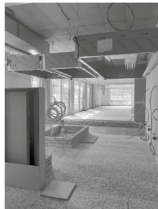
Küchenbereich mit Blick zum Speisesaal
