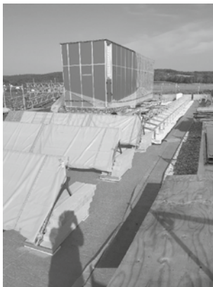
Dachaufbauten im Rohzustand
