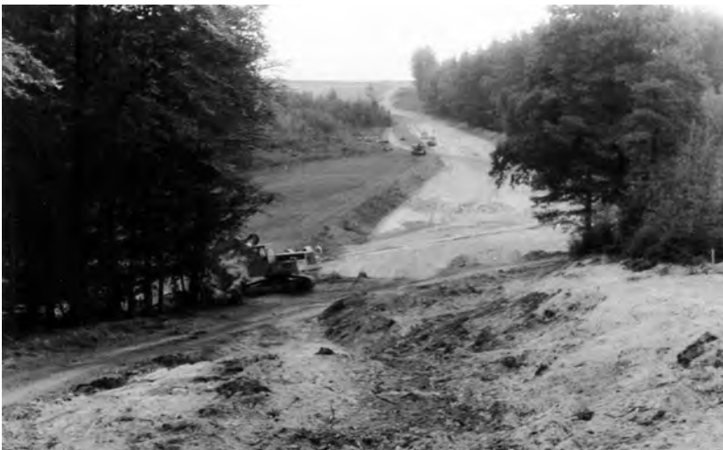
Straßenbau Riegling - Eilsbrunn, 1975
