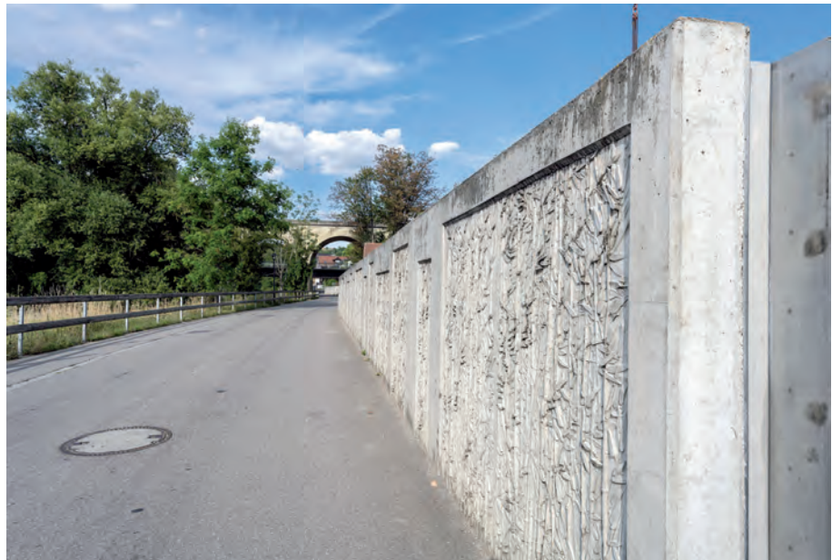
Hochwassermauer in Sinzing, 2022
