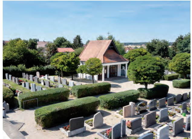
Friedhof Viehhausen mit neu gebautem Leichenhaus, 2022
