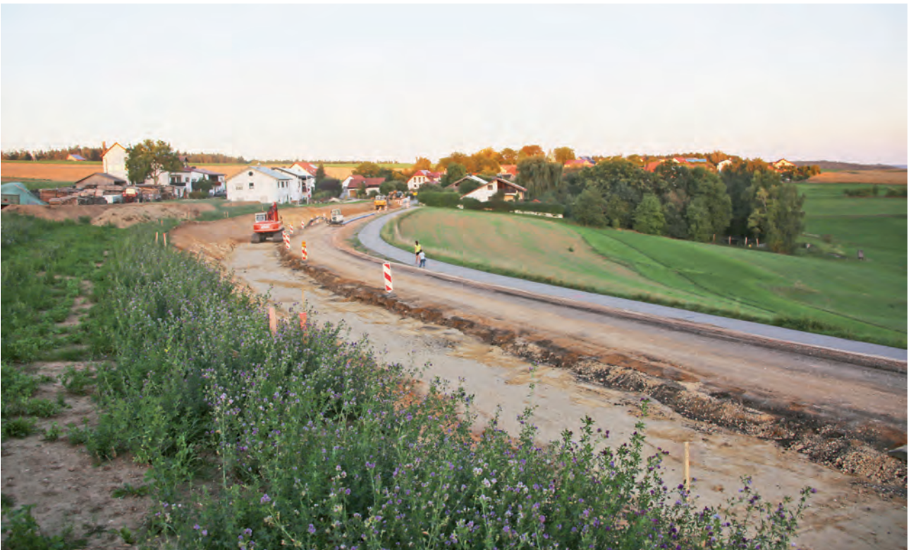
Erneuerung der Kreisstraße R51 zwischen Bergmatting und Saxberg, 2018
