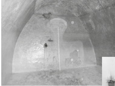
Foto 1: Brunnstube der historischen Wasserleitung Eilsbrunn, errichtet 1876.
